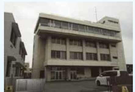
訓練施設（千葉県水道会館）
