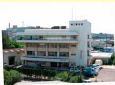
校舎 千葉県管工工会館
